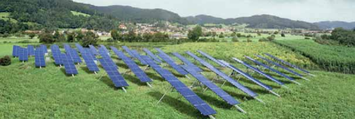
Estabelecimento de Rheinau. 28 sistemas de rastreamento SunCarrier 22, compactos e fáceis de instalar, geram um total de 135.000 kWh de energia por ano.
